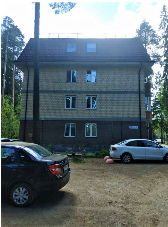
Фото № 1г. Фасад в осях «Г-А/1»
